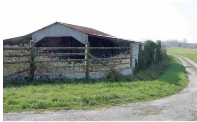
Grange au lieu-dit le Mas de Prieais
